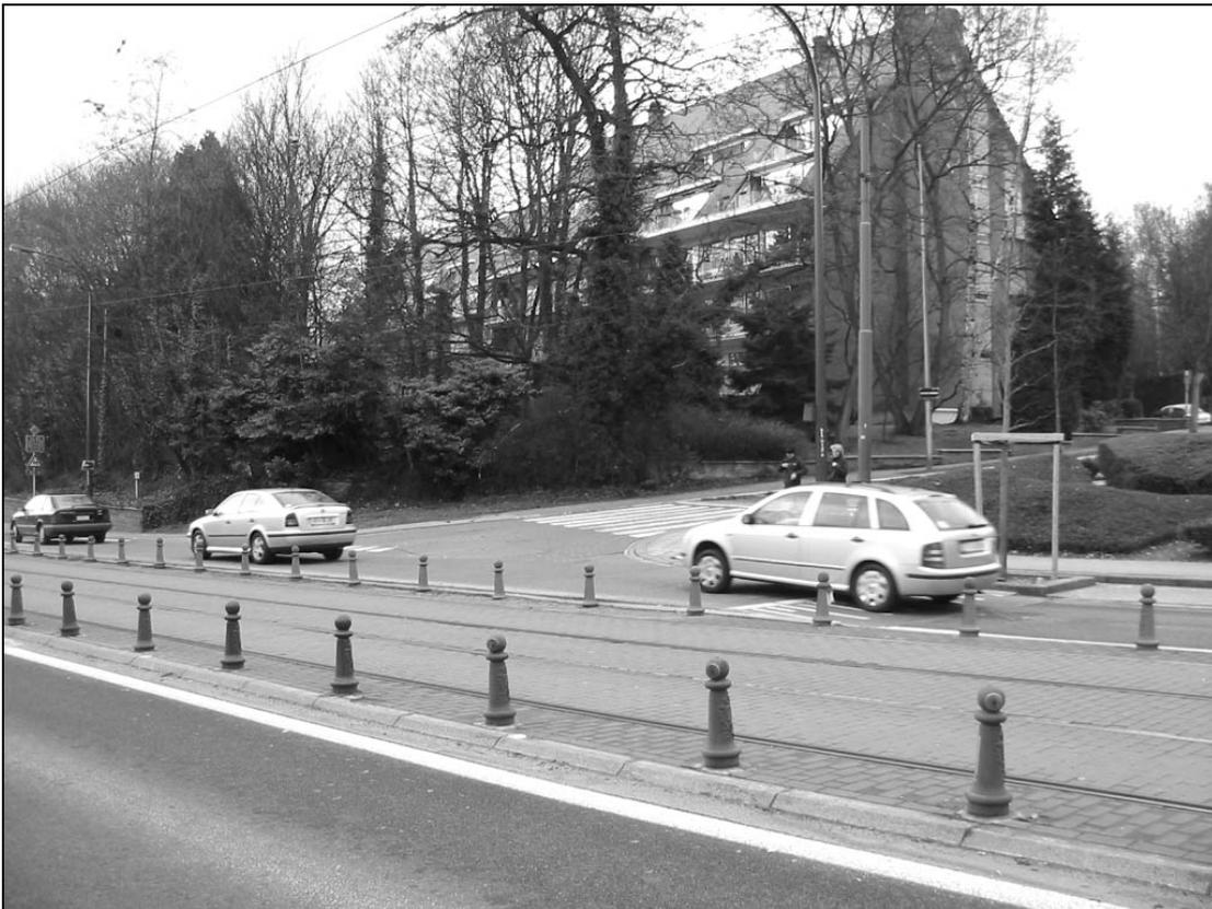
*Rue de Stalle, le site propre du tram est surelevé et « défendu » par des bollards pour empêcher que la chaussée soit traversée à hauteur des axes secondaires... et que ceux-ci soient empruntés par le trafic de transit.*
