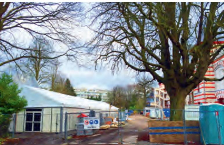
Février 2016, montage d'infrastructures temporaires devant les façades classées des Grandes Tribunes
