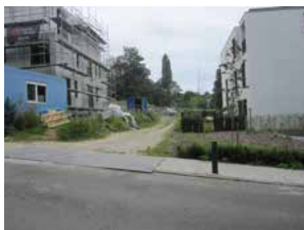
Accès carrossable qui donne accès à la nouvelle aile de la MRS l'Olivier rue Groeselenberg prévu par le PPAS mais réservé uniquement à la mobilité douce par la Commission de Concertation
