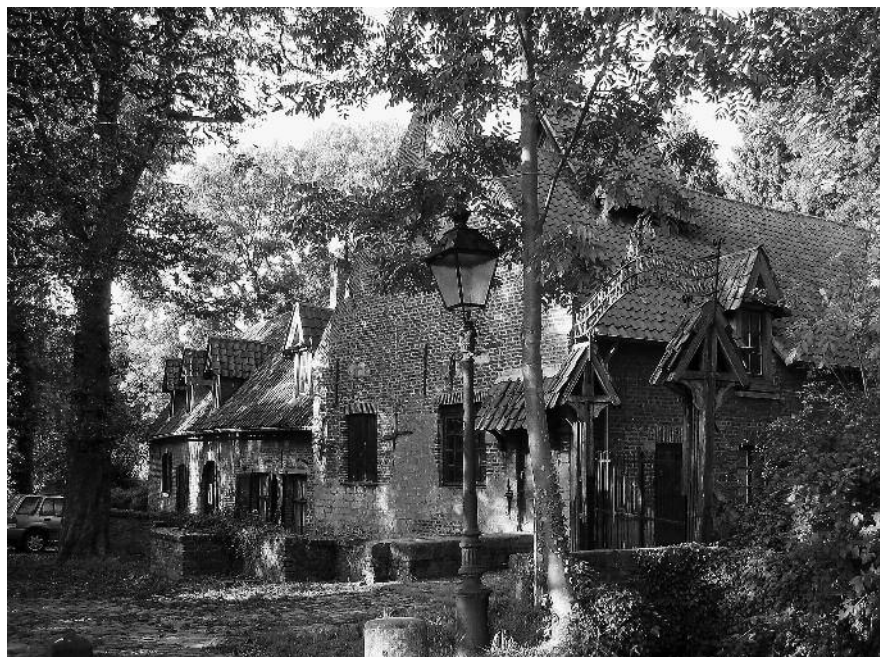
Le site du Keyenbempt est un site semi-naturel d'environ 10 ha, situé au carrefour du Bourdon, à l'angle des chaussées d'Alseberg et de Drogenbos. Il comprend la rue Keyenbempt, où est sis le moulin du Nekkersgat classé (photo ci-dessus), des espaces semi-naturels et des potagers (aménagés de chaque côté du ruisseau Geleytsbeek)
