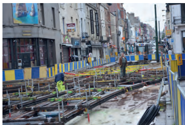
Des travaux gigantesques, au Globe croisement chaussée d'Alseberg/rue de Stalle
