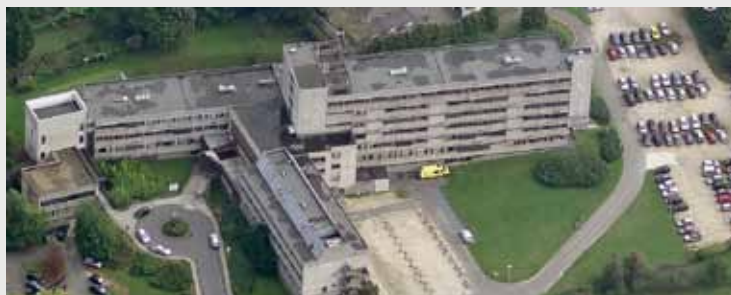
La Clinique des Deux Alice avant les travaux de transformation.
