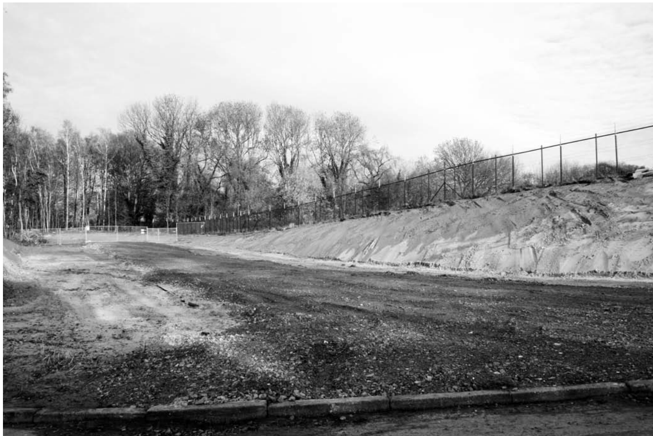
L'entrée de la future voirie
