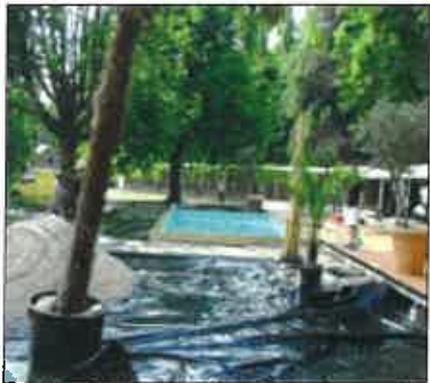
Photo 14 : Bâches Bidim déposées sur le sol
