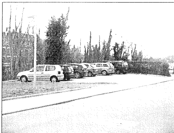
Photo 31 : Trottoirs rénovés avenue Latérale (côté chemin de fer)
