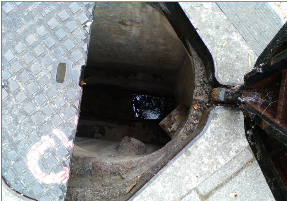
Chambre de visite de l'Ukkelbeek, octobre 2015
